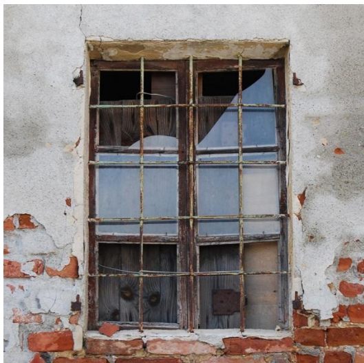
Comune di Cerreto – Grata metallica murata
