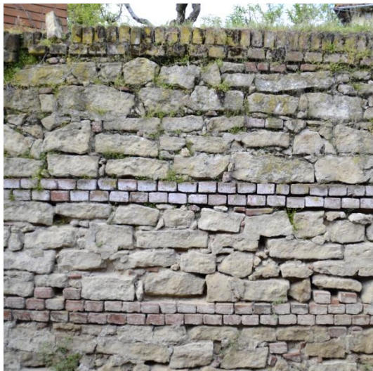
Comune di Cortazzone – Frazione Valmezzana
