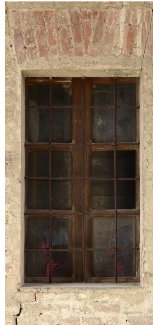
Comune di Roatto – Inferriata di sicurezza a tondi passanti
