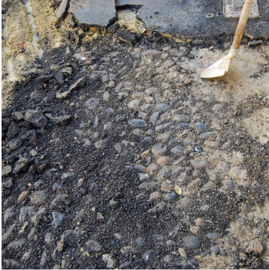
Acciottolato originale, reperito al di sotto dell'asfalto
