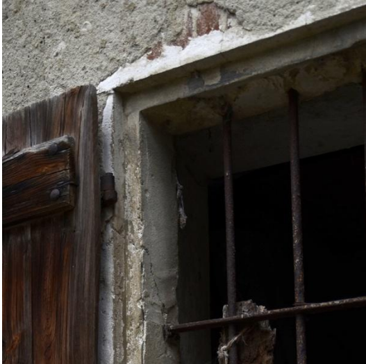
Riquadratura della finestra con gesso
