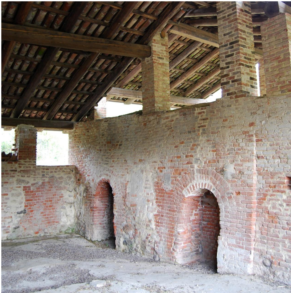
Comune di Castelnuovo Don Bosco – Frazione Bardella – Antico forno per la cottura del gesso
