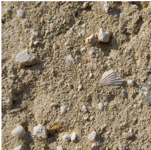
Ingrandimento di intonaco impastato con sabbia locale
