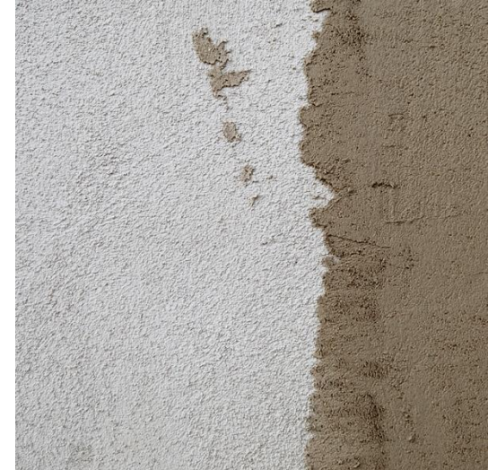
Intonaco di calce con finitura colorata in pasta
