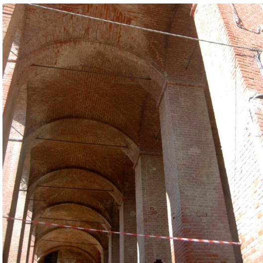
Comune di Frinco, opere di sostegno della piazza pensile
