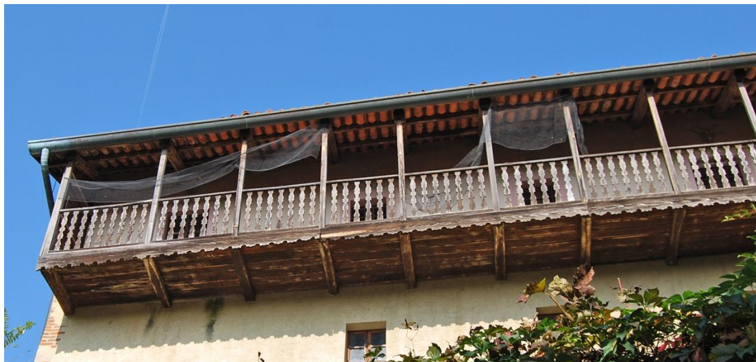
Comune di Pino d'Asti – Ballatoio in legno
