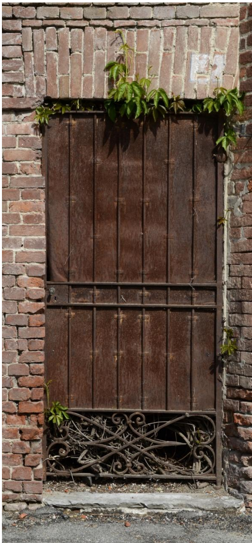
Comune di Roatto – Porta di accesso al cortile in ferro
